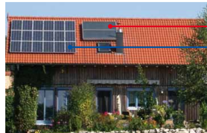
Abb. 5: Beide Nutzungsformen von Sonnenenergie auf einem Gebäude. H. Thiem
